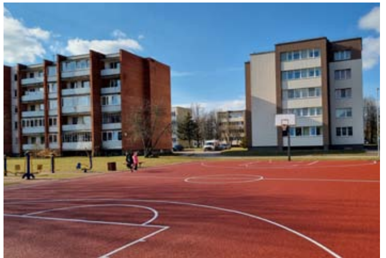
Seniūnija ėmėsi aikštelės atnaujinimo darbų: nuėmė seną dangą, paruošė pagrindą, o bendrovė „Sportinės dangos“ paklojo naują dangą ir nudažė linijas / Viečiūnų seniūnijos nuotrauka
